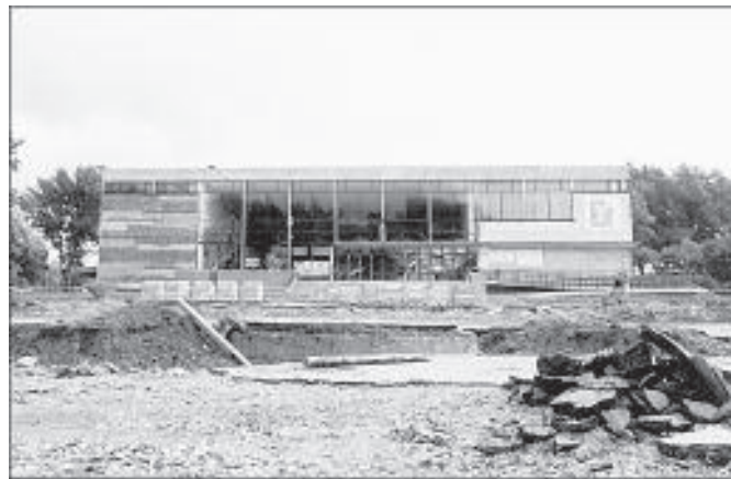
„Nerka” zdbiająca plac przed budynkiem OCK należy już do przeszłości Fot. /MB
